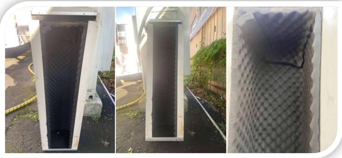
充電樁自主設計安裝降噪設備(隔音罩鋪設隔音棉)
